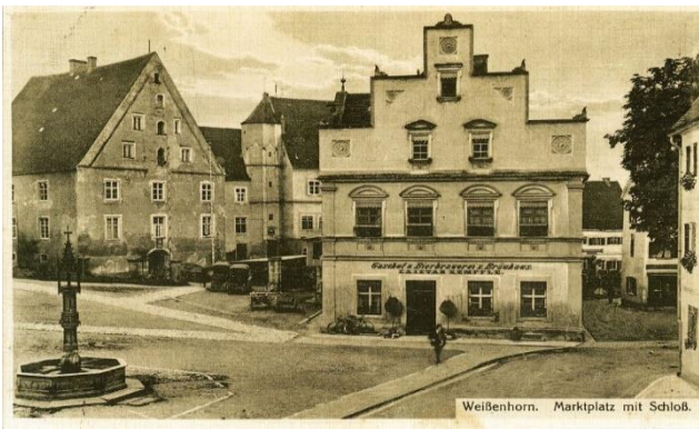
Blick auf die Schlösser und das ehemalige Bräuhaus um 1910
